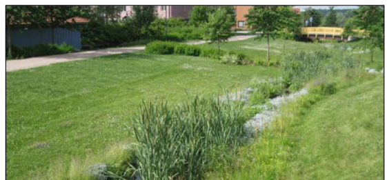
Kuva 22. Avo-oja puistomaisessa ympäristössä Vantaalla, ojan loivat reunat on helppo kunnostaa koneellisesti. Lähde: Hulevesien hallintarakenteet ja niiden kunnossapito, Ilmastonkestävä kaupunki.
